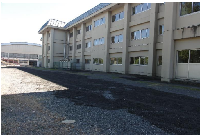
駐車場砕石敷き作業後
